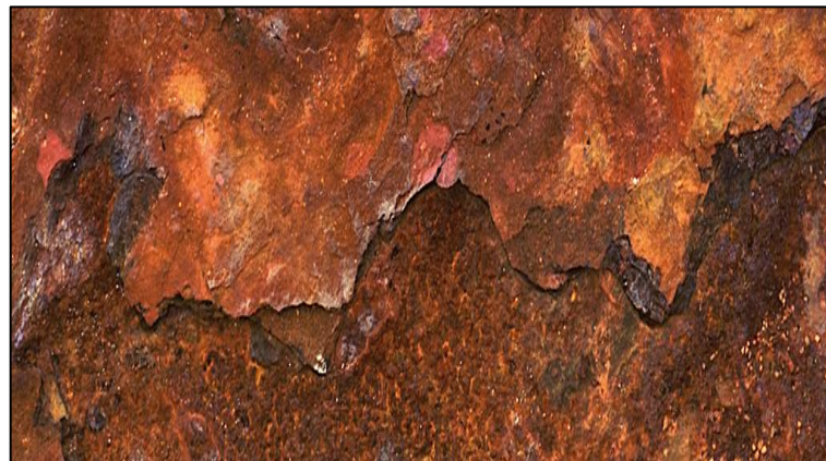
Figure I.2 : corrosion chimique : corrosion sèche [3].
