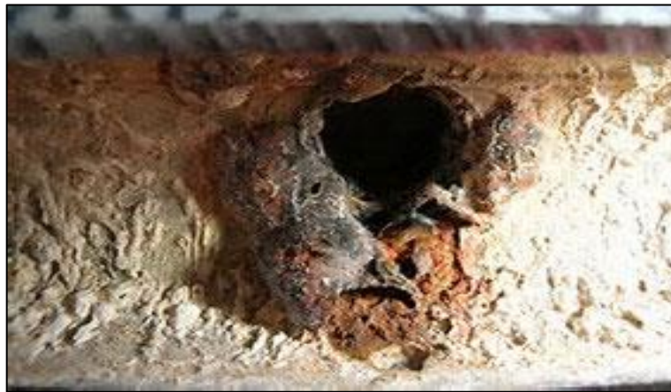
Figure I.3 : corrosion microbienne [4].
