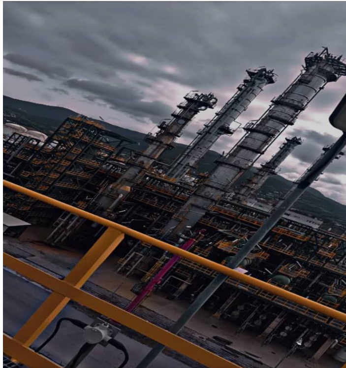
Figure 3.14 : Une Colonne De Distillation Dans la RA1K
