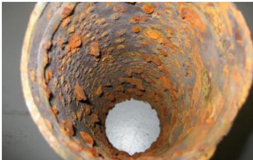
Figure I.2 : Corrosion microbiologique générale
