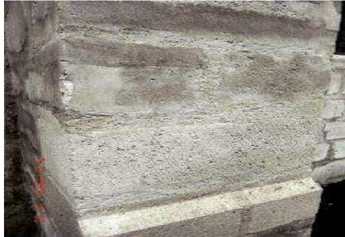
Figure I-10: Utilisation d'un mortier adapté au rejointoiement (crédit photo D. Poineau) (Le comité opérationnel de l'IDRRIM (2016))
