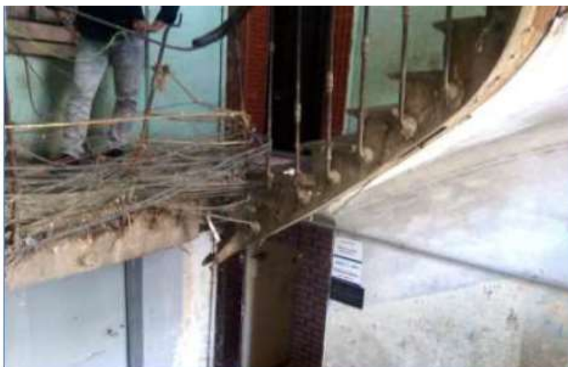
Figure II-7: Détail de l'état auquel se trouve jonction du montant d'escalier du bloc 14.04 avec le palier de l'escalier du premier étage
