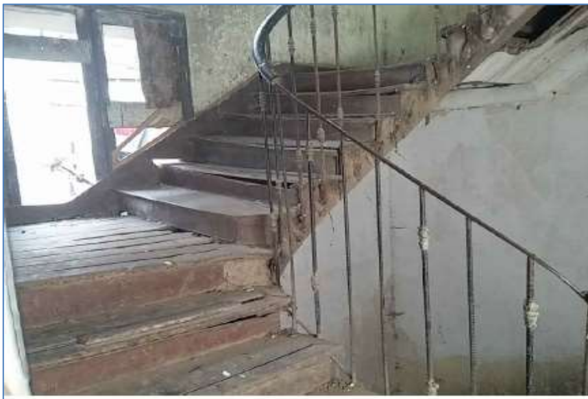
Figure II-6: Escalier du RDC au premier étage
