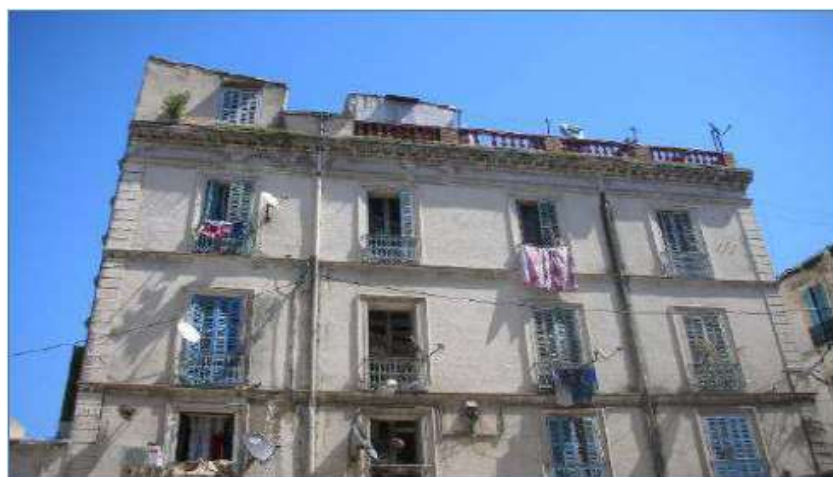
Figure II-15: Constructions ajoutées au niveau de la terrasse
