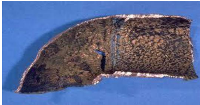
Fig. I.12: la corrosion par érosion.
