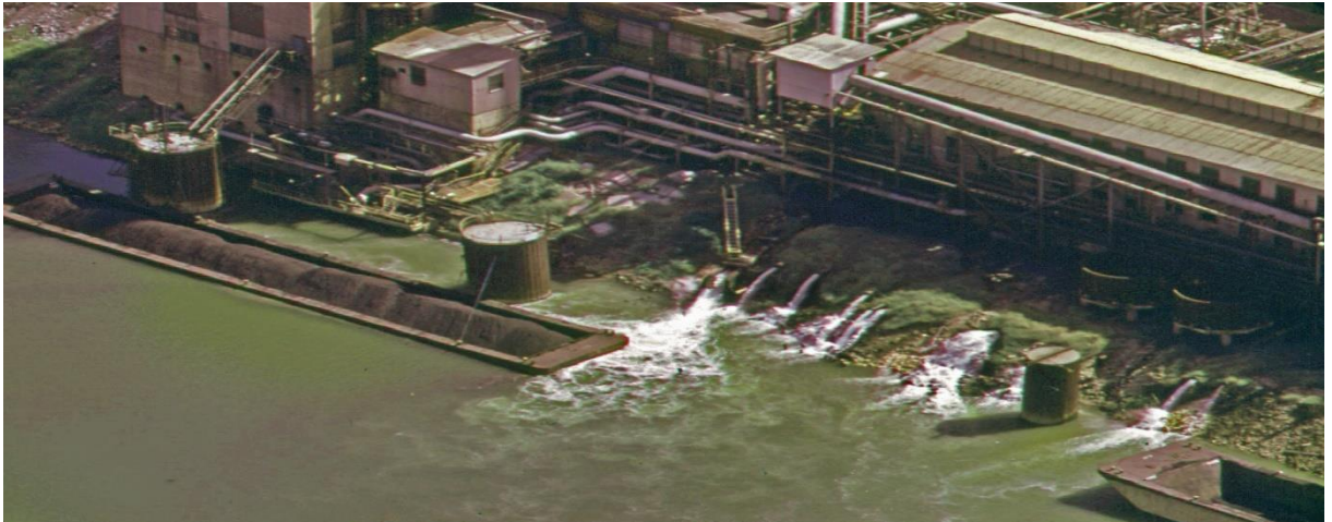
Figure I.2 : pollution de l'eau industrielle [2].
