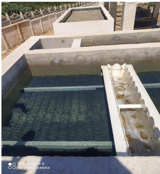
Figure III.5: Décanteur lamellaire de la station
