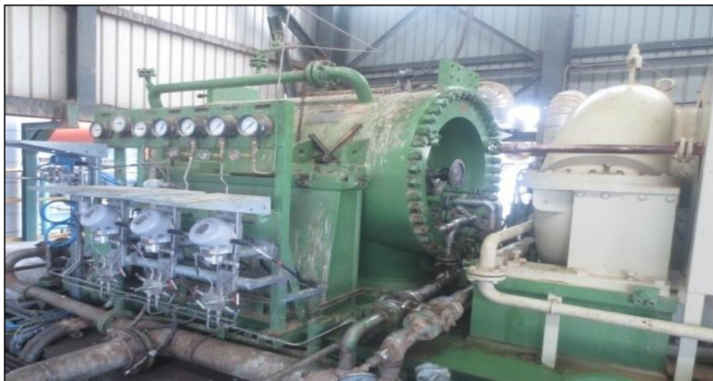
Figure. IV.1. Installation du compresseur centrifuge
