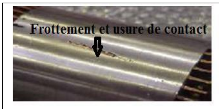
Figure II.20. Défaut de frottement.
