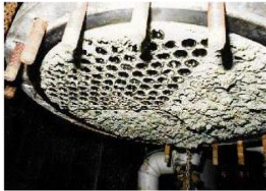
Figure II.13 : Bouchage des Tubes d'échangeur dû à l'encrassement.
