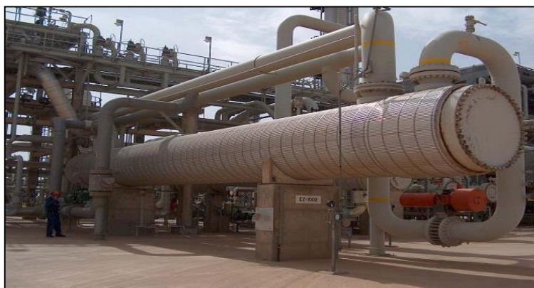
Figure. II.1: Un Échangeur de chaleur
