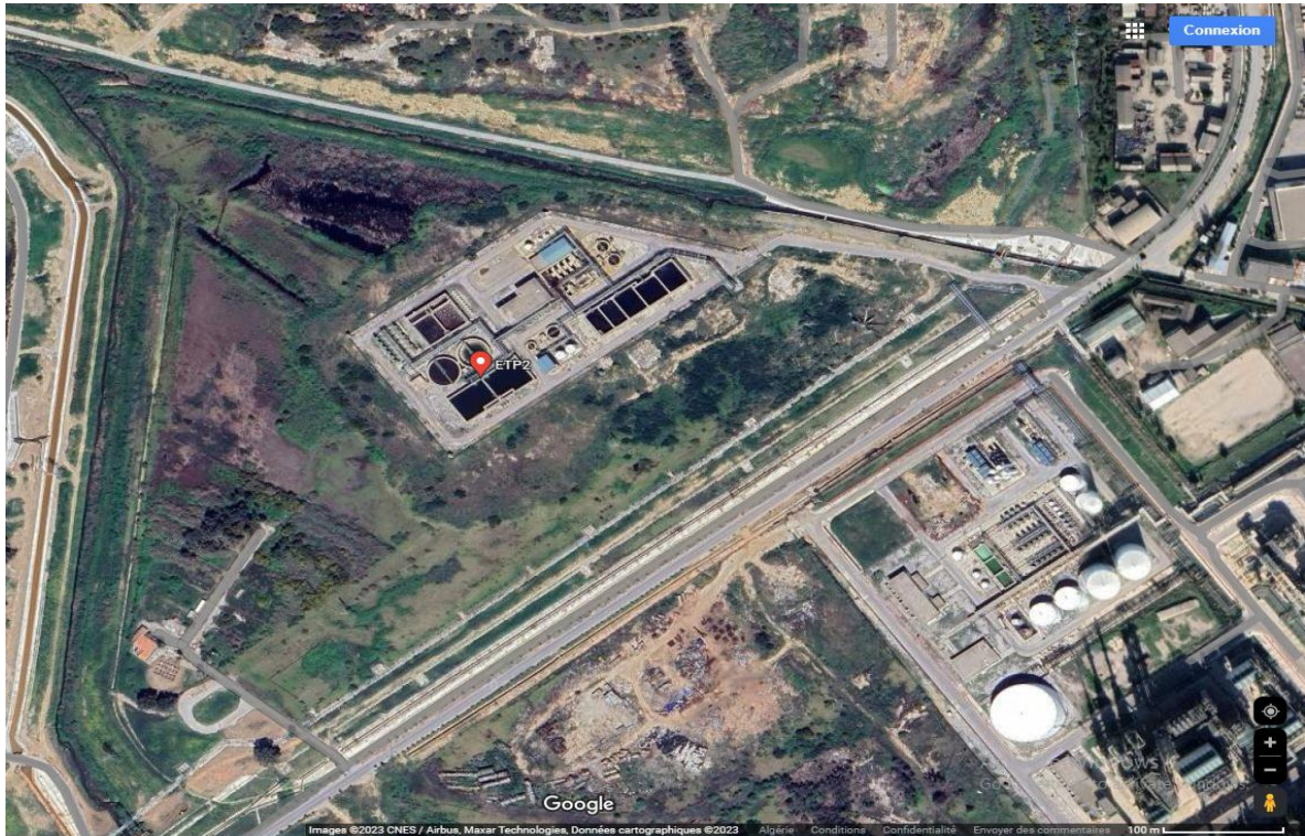
Figure II.3 : Image satellitaire montrant l'unité de traitement des effluents d'ETP 2 (Google Earth).
