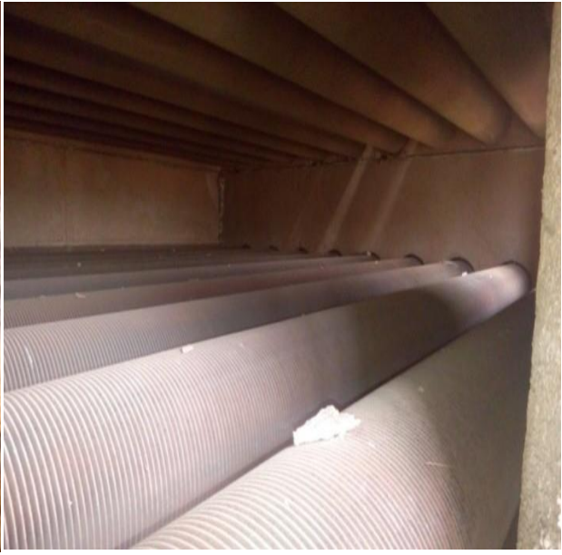
Figure II. 17 : Partie supérieure de la zone de convection avec des tubes ailetés [22]
