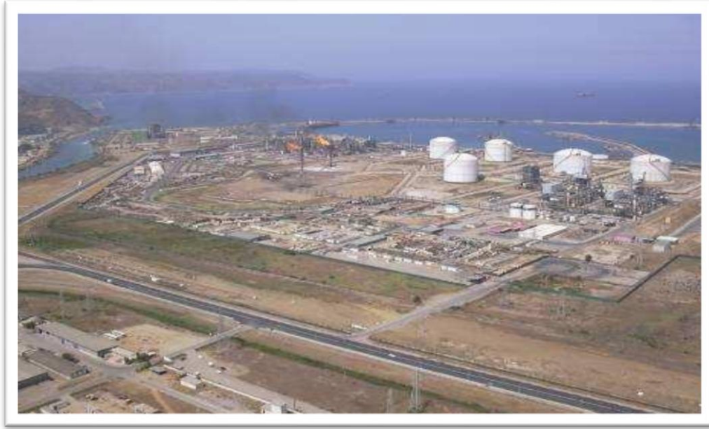
Figure I- 3 : Vue panoramique du complexe GL1K
