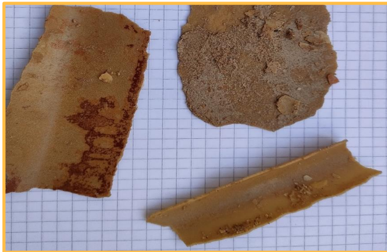
Figure IV.18 : Echantillon d'un dépôt du tartre sur les tubes de l'évaporateur.
