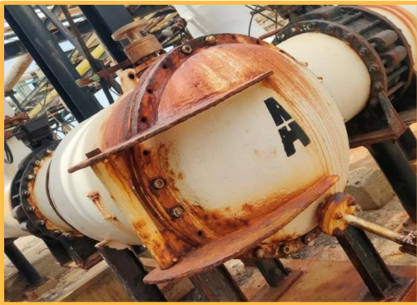
Figure IV.6 : Corrosion et vieillissement de la peinture des viroles et couvercles des filtres.
