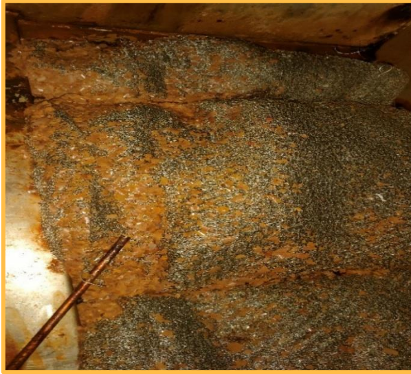
Figure IV.11: Encrassement des démisters et du fond de la 6 ème cellule.
