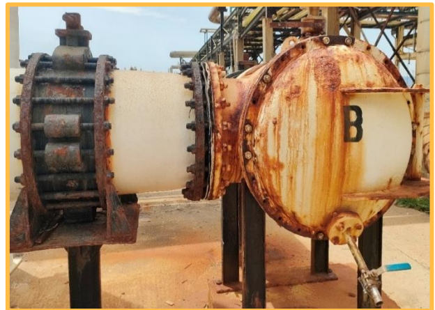
Figure IV.6 : Corrosion et vieillissement de la peinture des viroles et couvercles des filtres.
