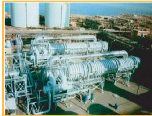
Figure I.6 : Schéma de principe d'un système de Distillation par détentes successives (MSF) Tripoli, Libye [10].
