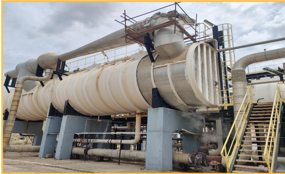
Figure IV.4 : L'évaporateur TCD 6-8000.
