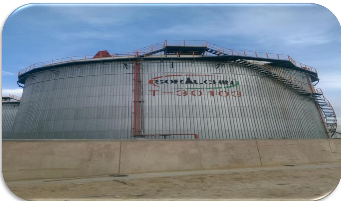
Figure V.1. : représente Bac de stockage du brut T- 3010
