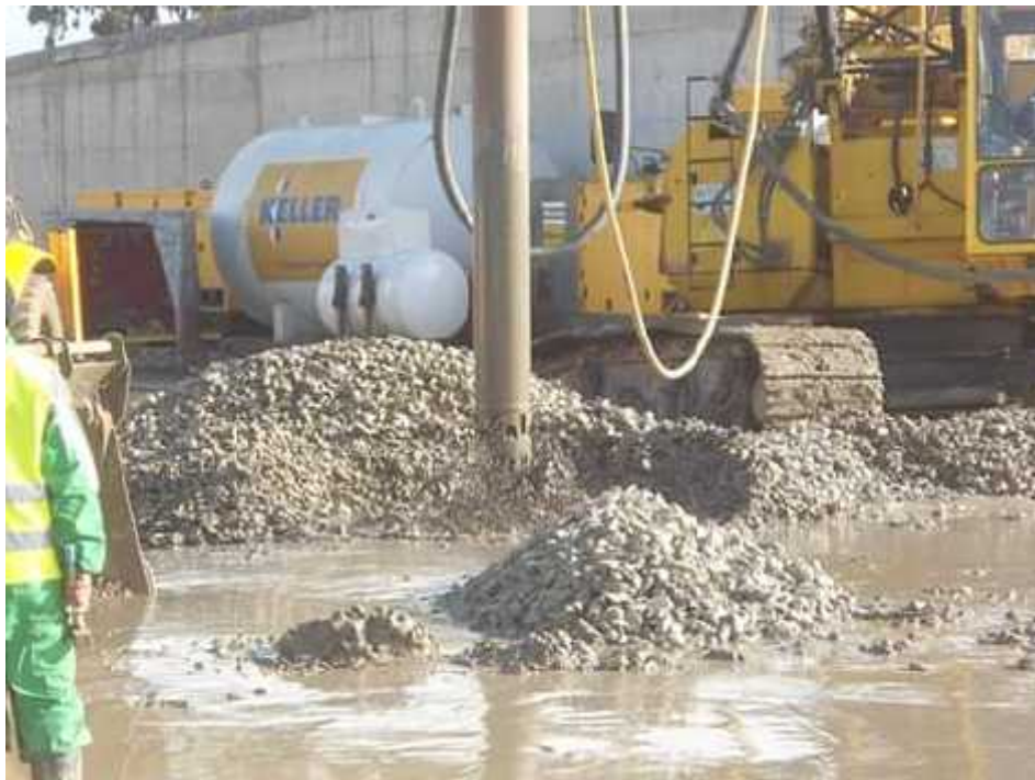
Fig. 3.7 : Réalisation d'une colonne ballastée
