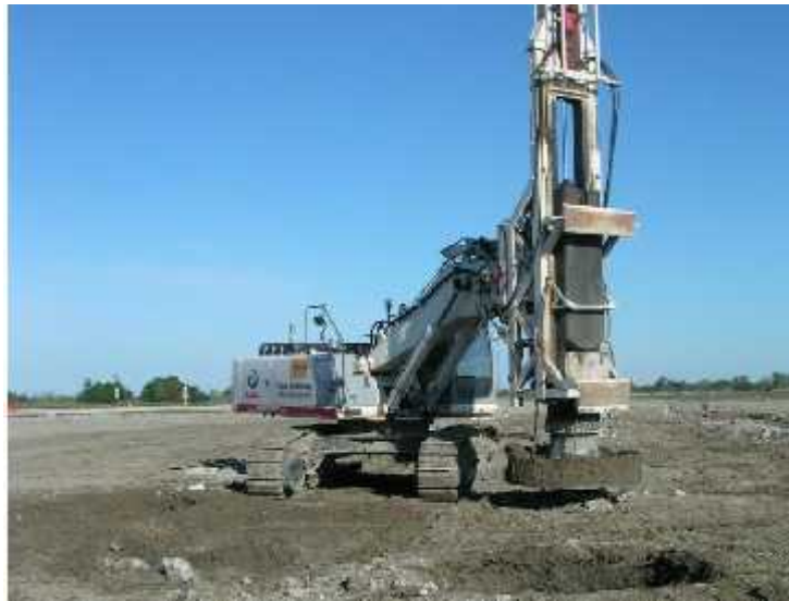
Fig. 1.14 : Engin utilisé pour la réalisation des plots ballastés (Keller, 2019)
