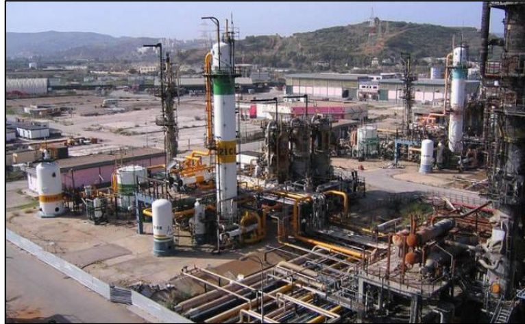
Figure 1.2 : Vue sur la raffinerie de Skikda RA1K.
