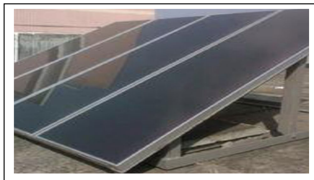
Figure 1. 6 Le panneau photovoltaïque en silicium amorphe
