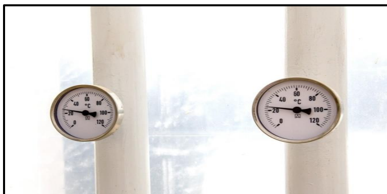
Figure 24 : chauffage d'une serre
