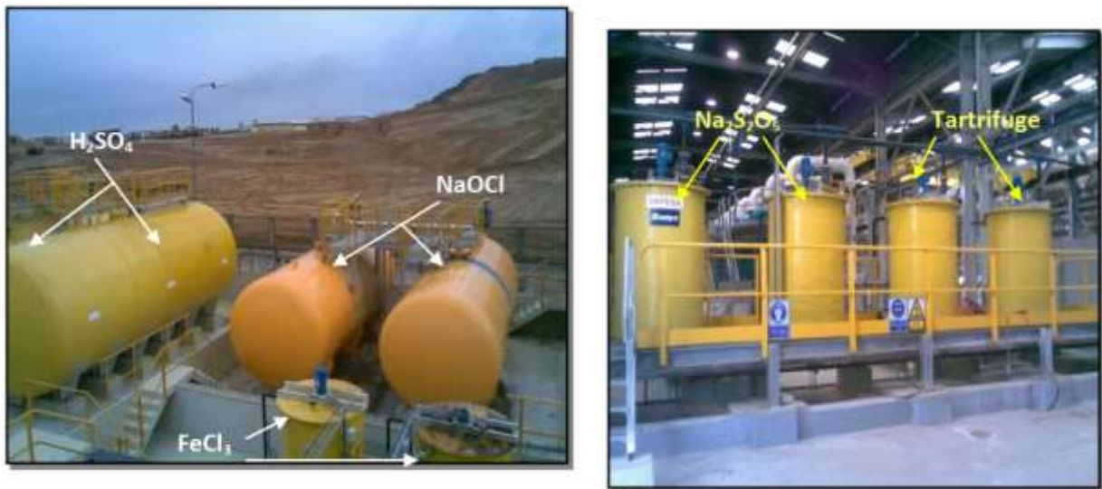
Figure20. Citernes des produits chimiques.
