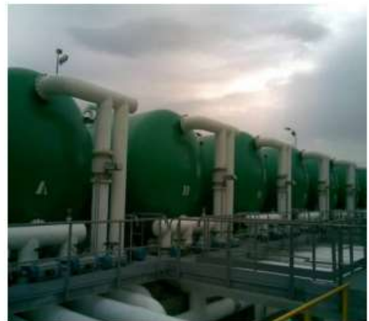
Figure 18. Les bacs de filtration .
