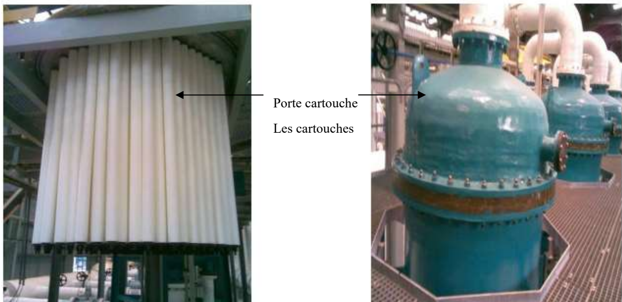
Figure 19. Les filtres à cartouche .
