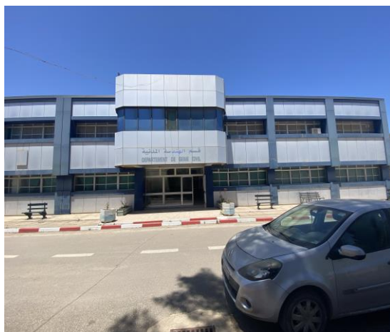
Figure 33: vue principale du département de génie civil source : Auteurs, 2024
