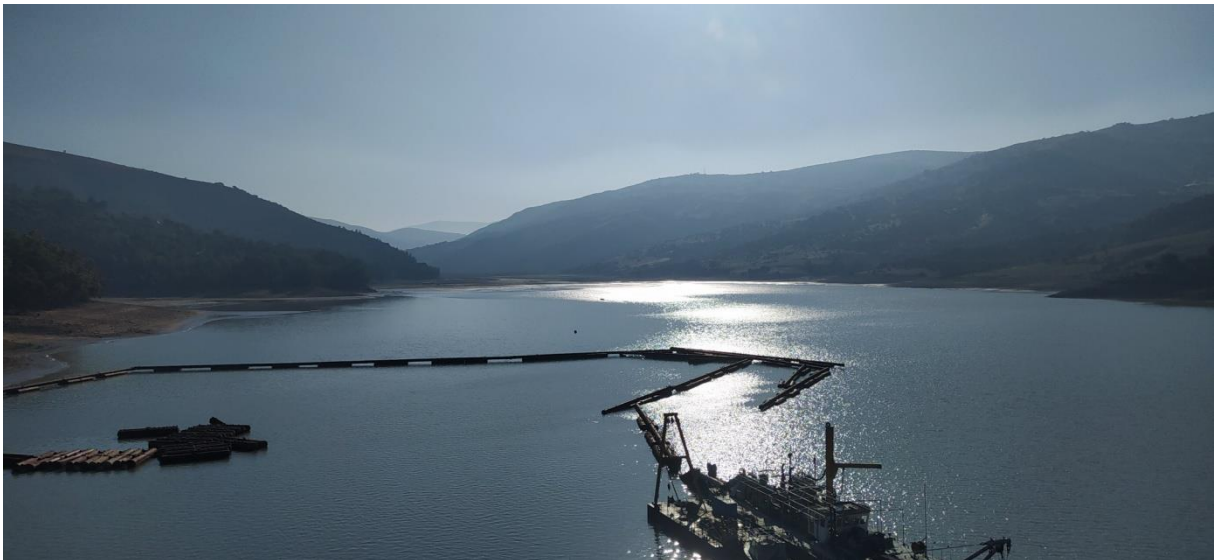
Figure 1 : Photographie personnelle du barrage Zardezas-Skikda.
