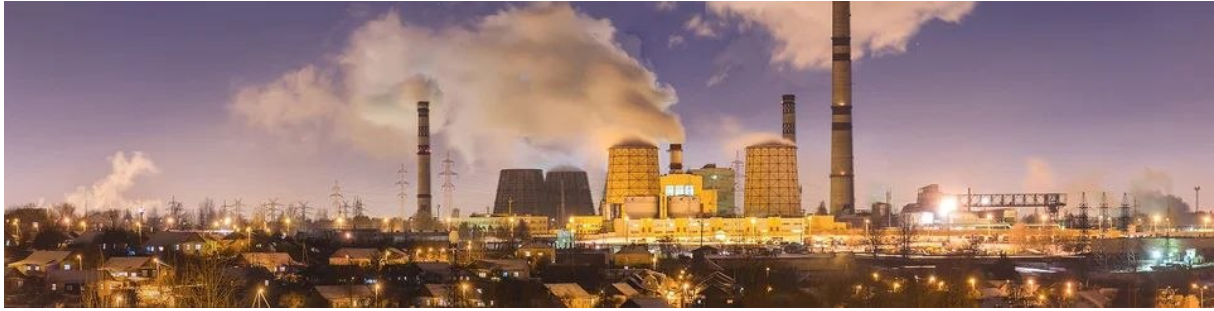
FIGURE 4.1 – Une centrale de production d'énergie
