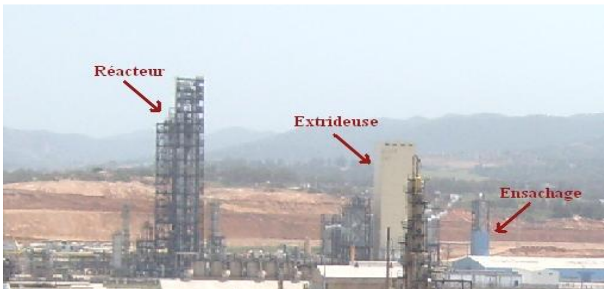
Figure 3.4: Photo représente les principales installations de l'unité CP2K. (Unité CP2K, 2025)
