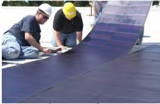
صورة 28: تثبيت الألواح الشمسية ذات الأغشية الرقيقة
