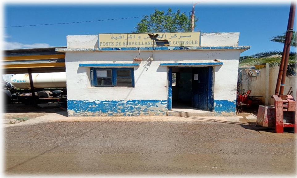
Figure 04 : le poste de surveillance et contrôle
