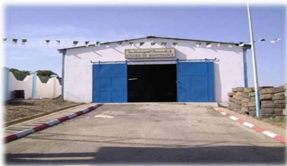
Figure10: L'atelier de maintenance. (CET Zef-Zef)
