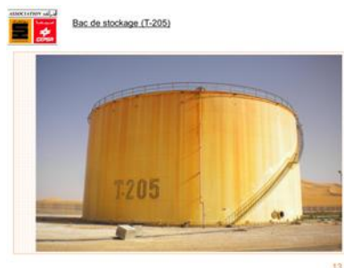
Figure I-3 Bac de stockage du pétrole brut
