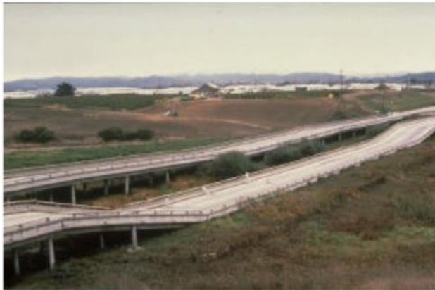
d) Effondrement de Struve Slough sur la route 1, tremblement de terre de LomaPrieta en 1989. Le vide adjacent au pieu (Meymand 1994).
