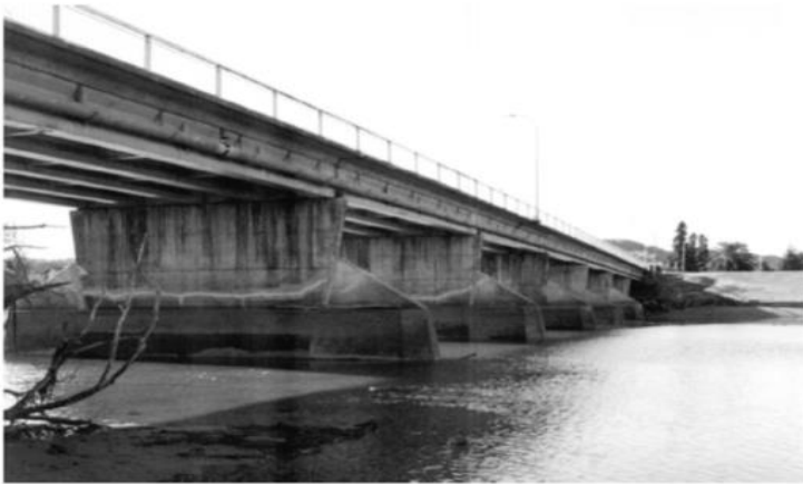
c) Dommages aux pieux et aux piliers du pont du chemin Landing, Séisme de 1987 à Edgecumbe (Berrill et al. 2001).
