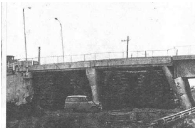
a) Endommagement de la culée et des piles du pont Yachiyo, tremblement de terre de Niigata en 1964 (Abdoun et Dobry 2002).
