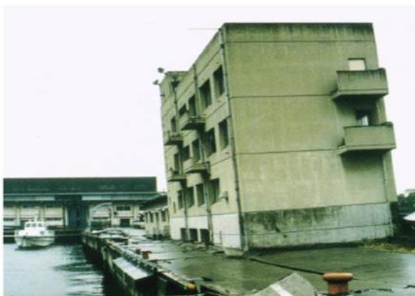
e) Basculement d'un bâtiment de 3 étages soutenu par des pieux, tremblement de terre de Kobe en 1995. Formation de fissures dans les éléments de pieux. (Bhattacharya et al. 2009).
