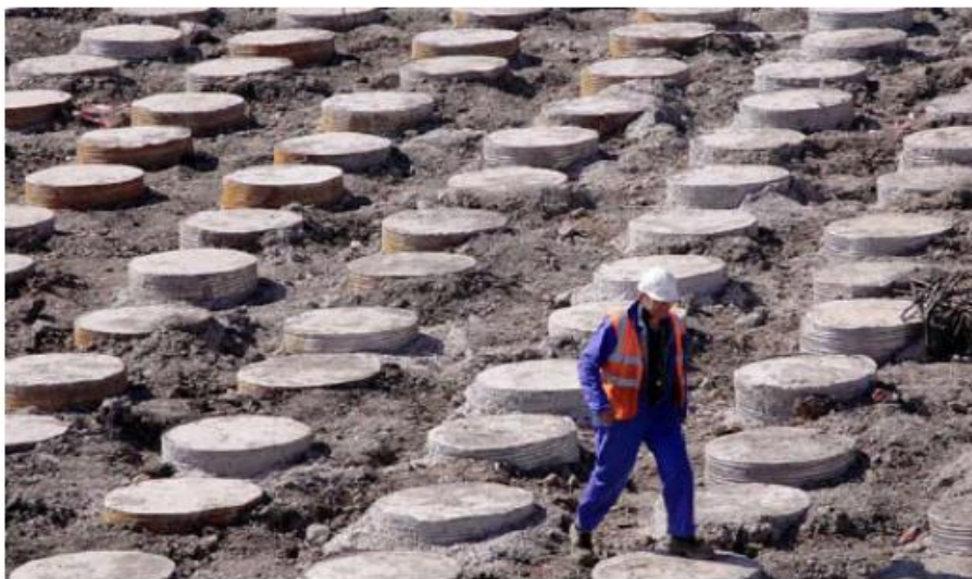
Figure 1.7- Inclusions rigides dans une disposition rectangulaire (Villard, P., & Briançon, L. 2018).
