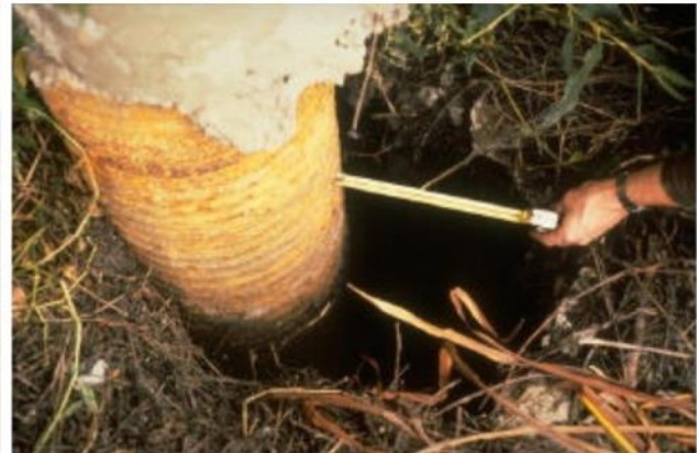
d) Effondrement de Struve Slough sur la route 1, tremblement de terre de LomaPrieta en 1989. Le vide adjacent au pieu (Meymand 1994).
