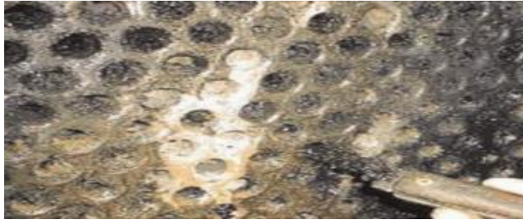
Figure I-15- Encrassement par réaction chimique [24]
