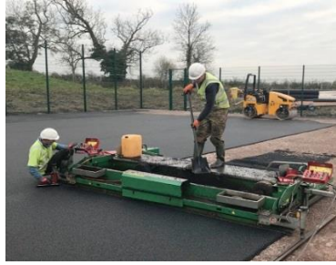
e-Technologie de l'asphalte caoutchouté.
