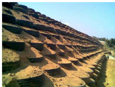
c-Pose des nappes de pneus Projet pilote – Route de Bousmail.
