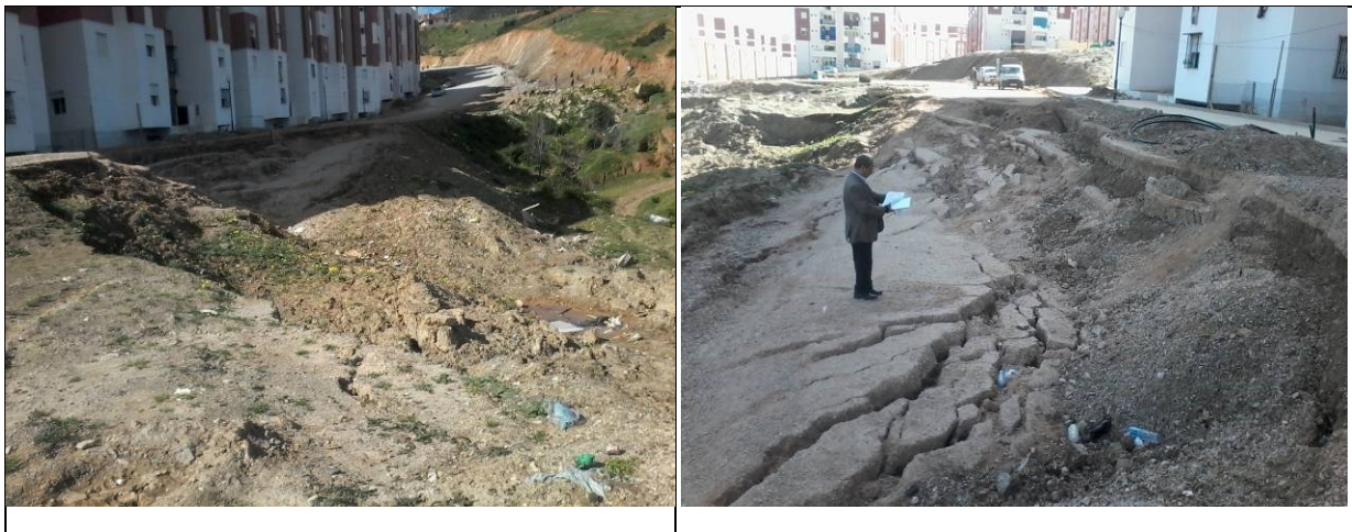
Figure III.15 : Vue du glissement Messiouene-Skikda, mars 2018.
