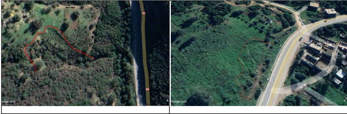
Figure III.8 : glissements de terrain observés sur la RN 43 pendant des périodes non déterminées + image de Google Earth.
