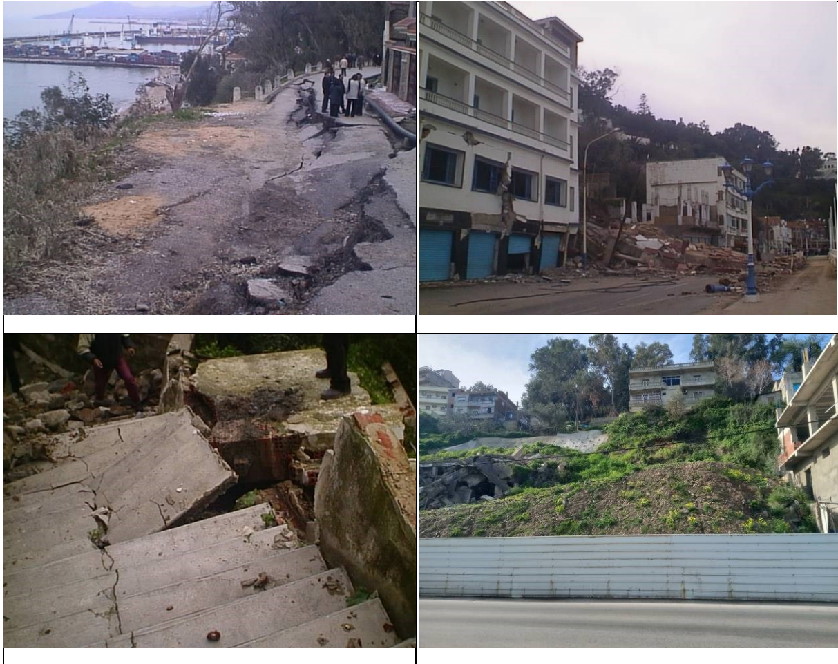
Figure III.11 : Illustration des glissements de terrain affectant la corniche de Stora et leurs impacts sur les infrastructures.
