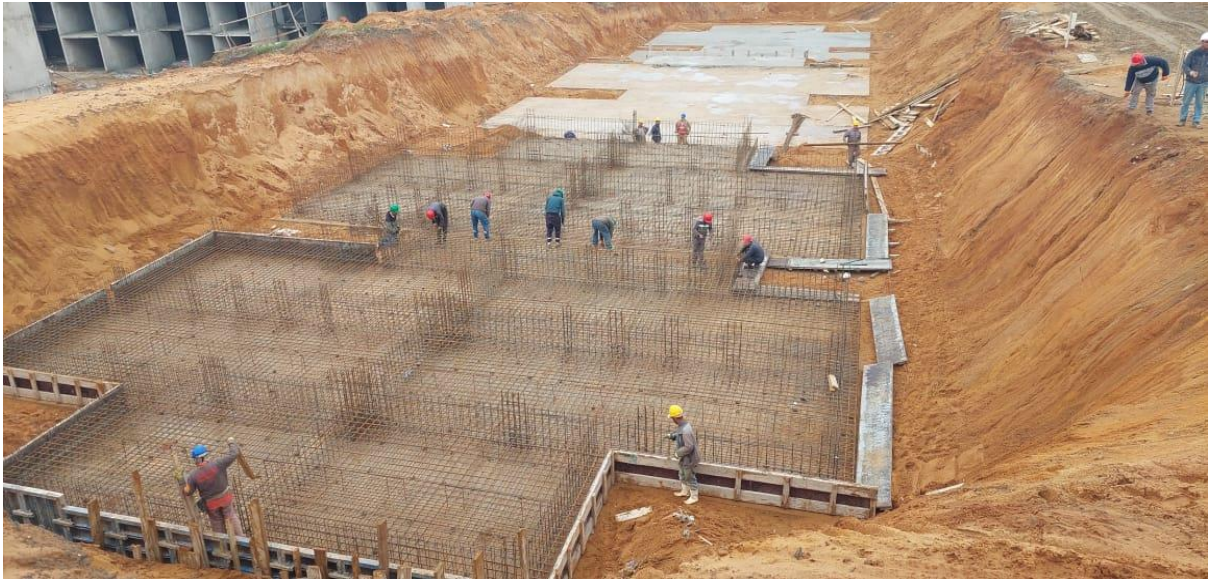
Figure I-2 Ferrailage radier général
