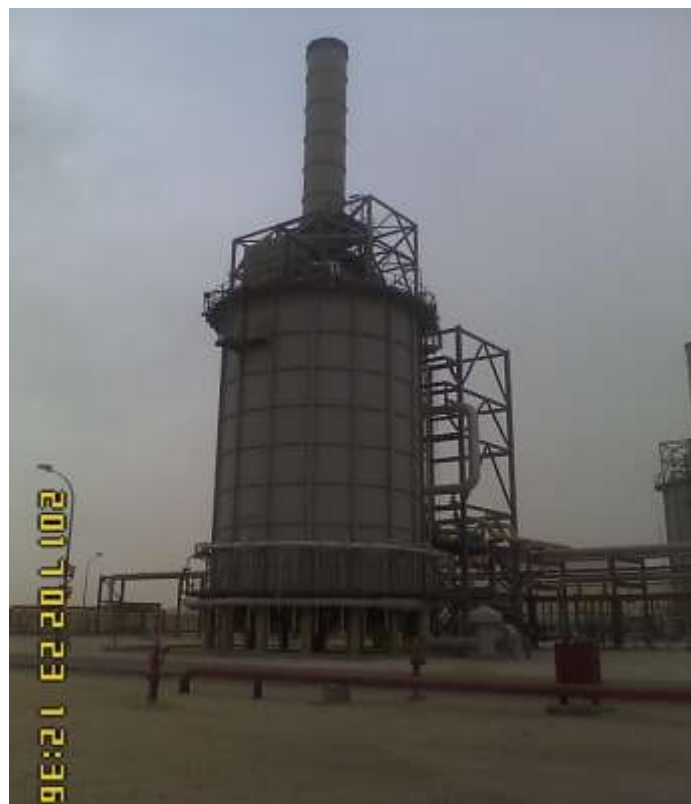
Figure II.8 : Le four rebouilleur.
