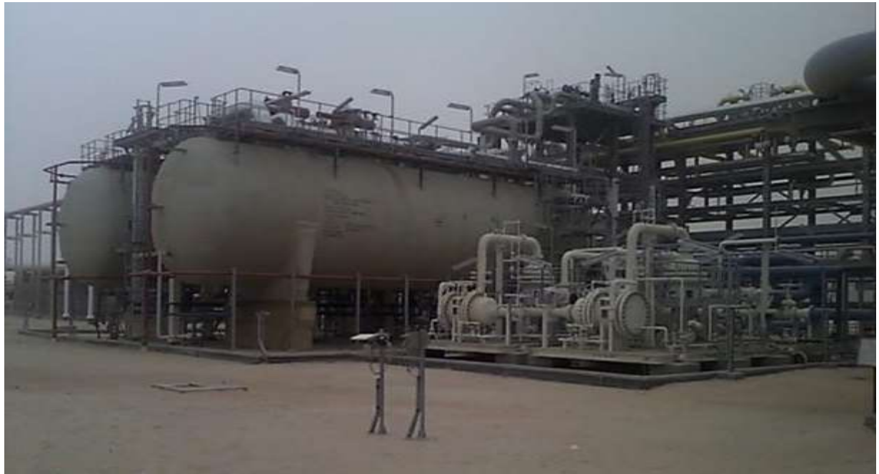
Figure II.2 : Les séparateurs A/B.
