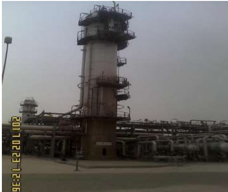
Figure II.7 : La colonne de stabilisation.
