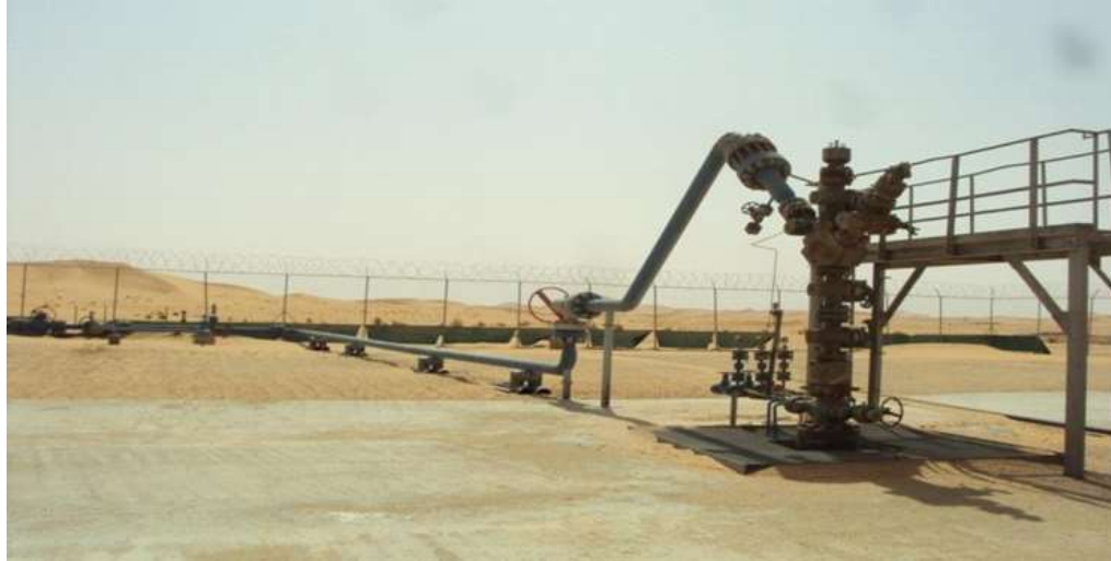
Figure I.9 : Puits injecteurs d'eaux.
