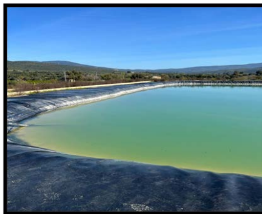
Figure 10 : Photo des bassin geomembrane prise par les étudiantes
