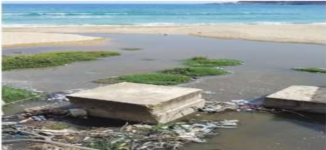
Fig.7 : Plage menacée par les eaux usées à cause d'une station de refoulement en panne depuis des années Collo (Skikda ; 2021).
