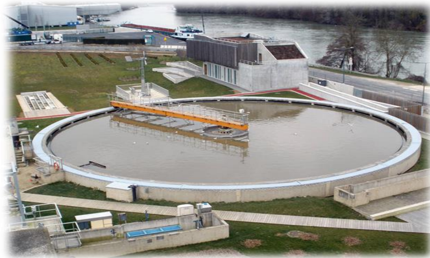
Figure II.8 : décanteur secondaire « clarificateur » [46]
