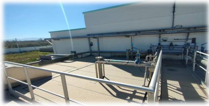
Figure III.5 : Déshuilage-Dessablage.
