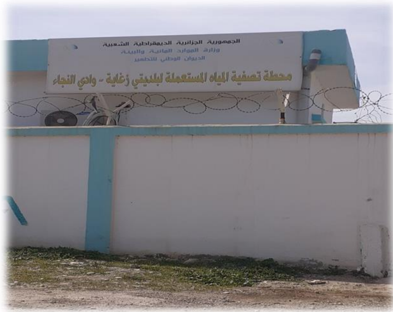
Figure III.1 : La station d'épuration de Zeghaïa — Oued Endja.
