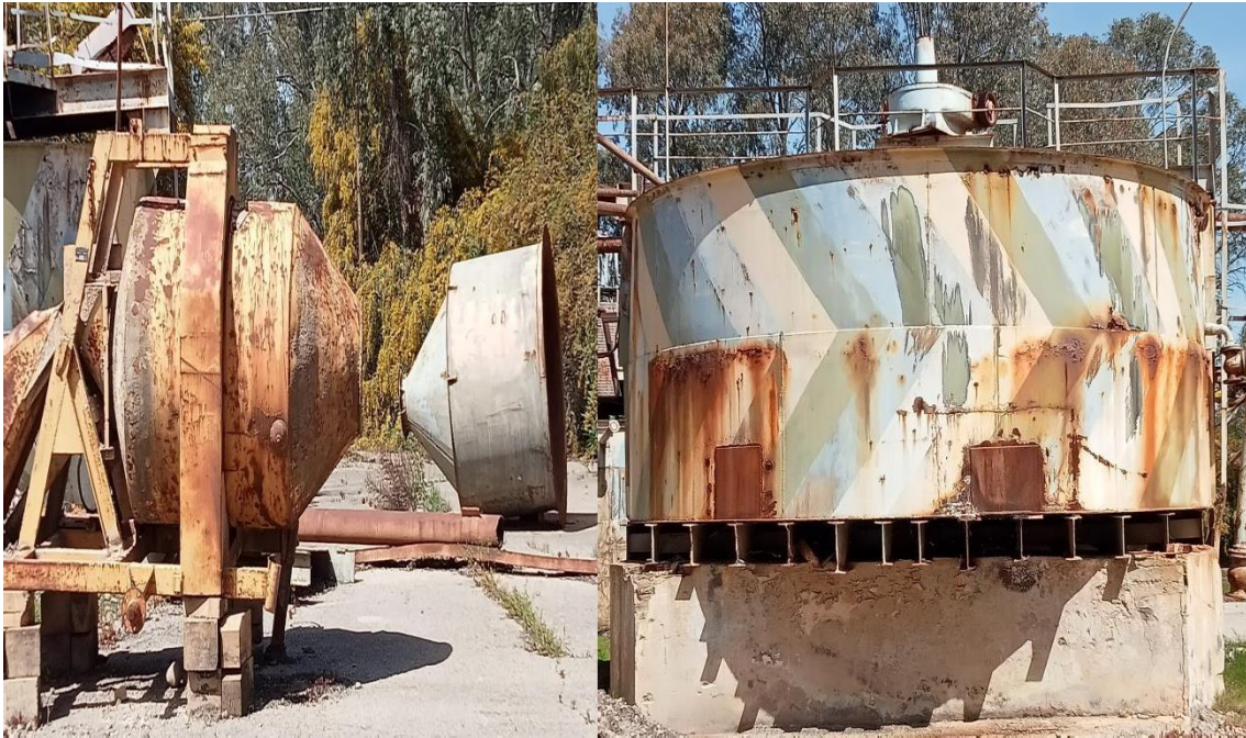
Figure 13. Les trémies d'alimentation (sortie du 11Avril 2022)
