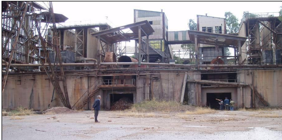
Figure 06. Déchargement des fours (scories)
