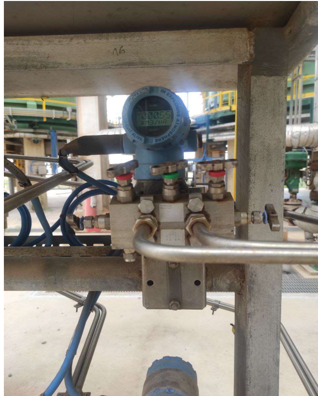
Figure 2.16 Transmetteur de pression .
