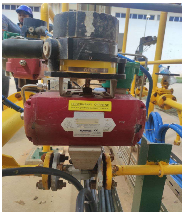
Figure 2.23 La vanne d'évent ( bleed valve ) .
