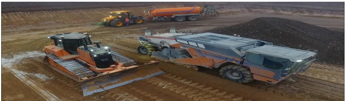
Figure II.17 : Traitement de sol au ciment aéroport de Liège
