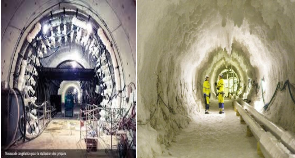
Figure II.15 : Travaux souterrain : la congélation des sols
