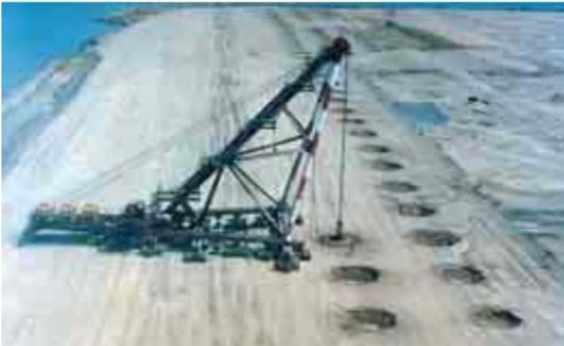
Figure II.7 : Chantier de compactage dynamique ( aéroport de Nice-France)(documents de Ménard soltraitement®)
