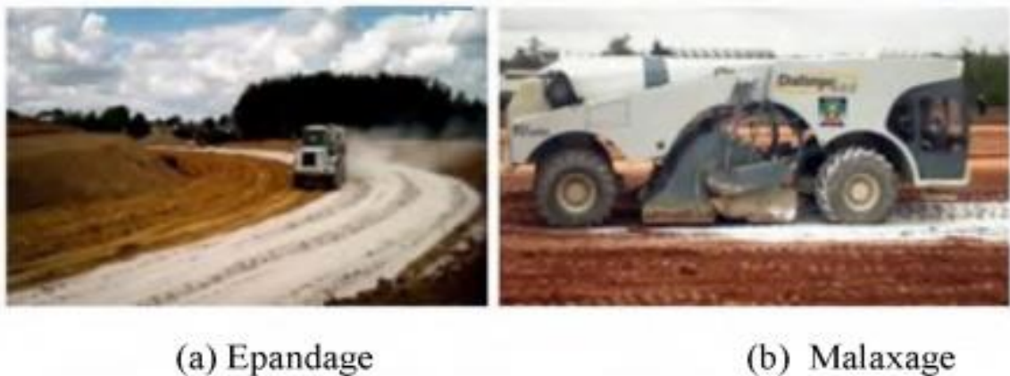
Figure II.18 : Chantier de traitement d'un sol à la chaux
