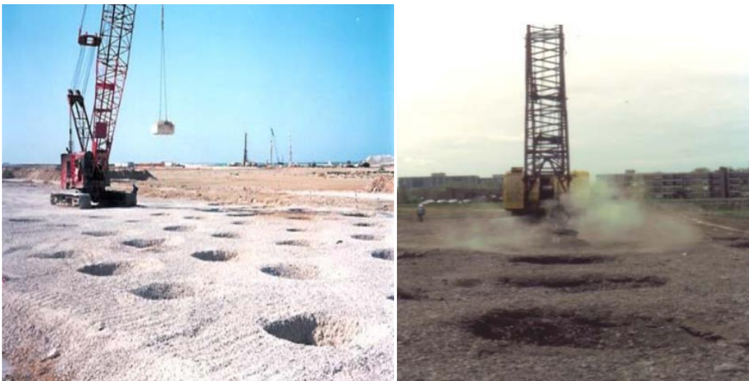
Figure II -4 exemples de chantiers de compactage dynamique (documents de Géopac® et Ménard et sol traitement®)
