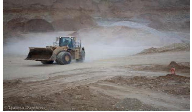
Figure 66. Le déplacement des engins.
