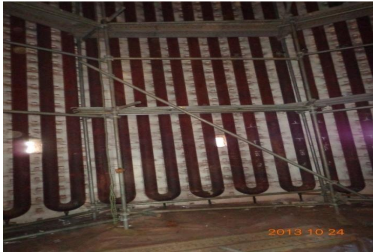
Figure II. 16 : Disposition des tubes dans la zone de radiation [22]
