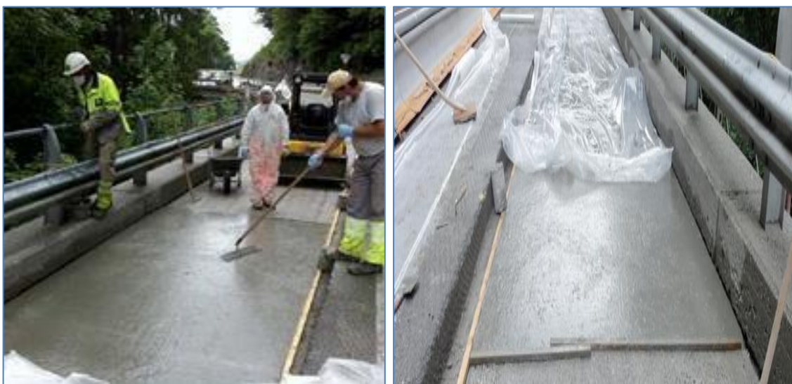
Figure I.5: Exemple de mise en place d'un BFUP
