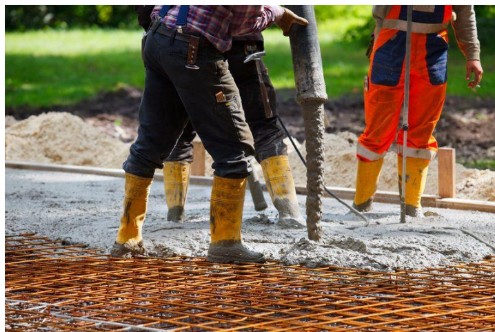
Figure 3-3: mise en place du BPE
