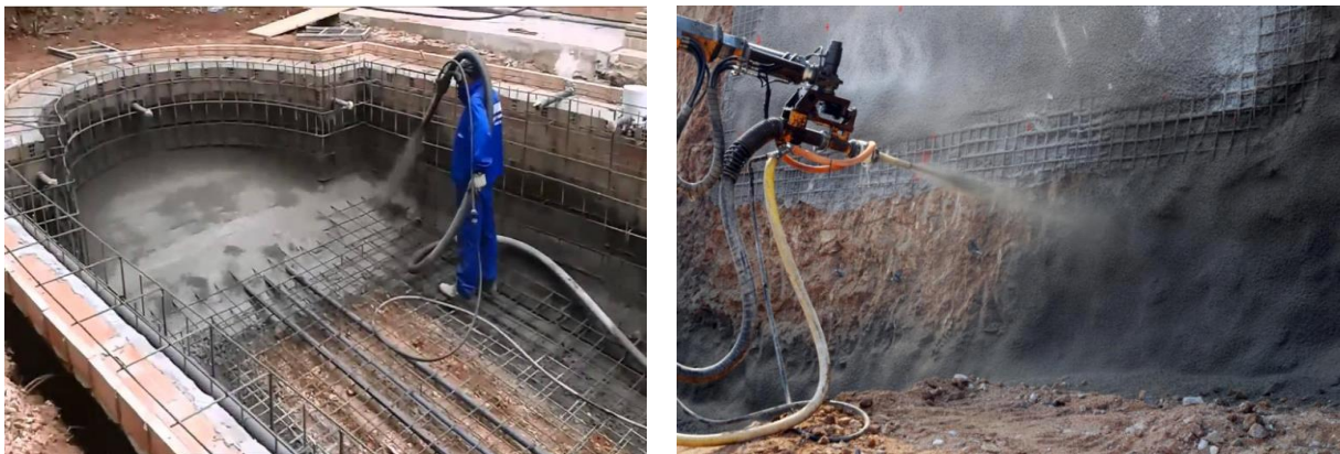
Figure 5-1 : les bétons projetés
