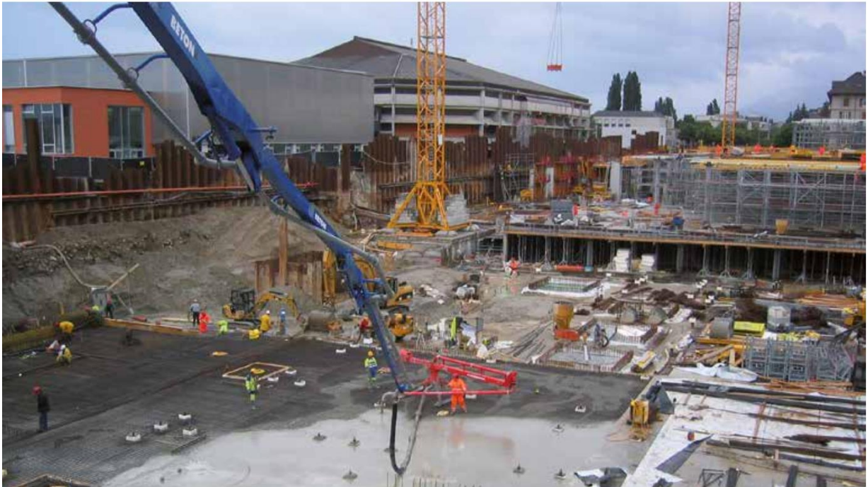
Figure 6-1: Le béton pompé
