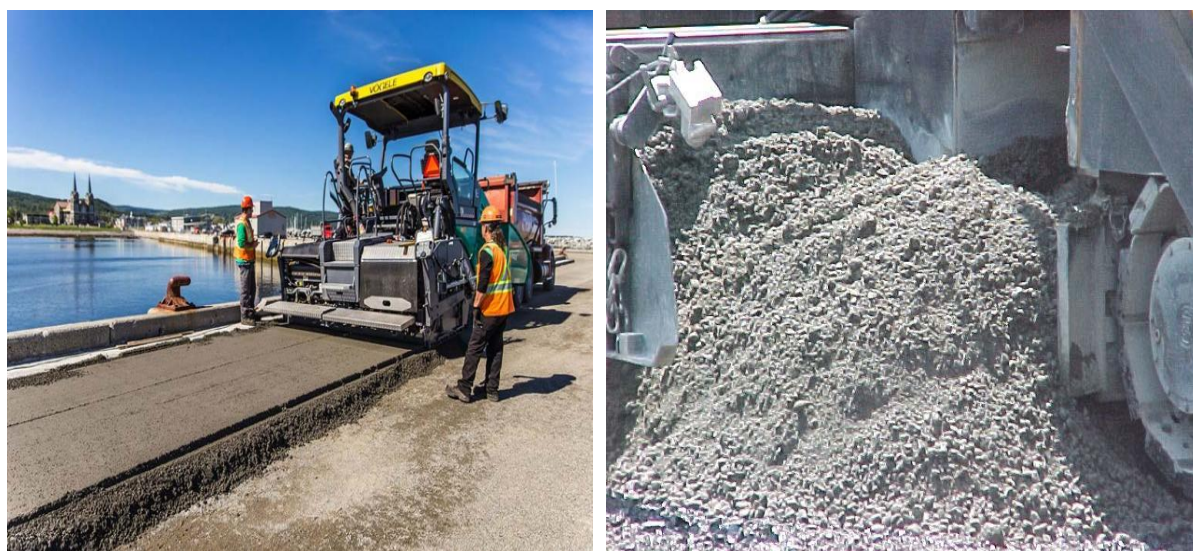
Figure Figure 2-6 : béton compacté au rouleau
