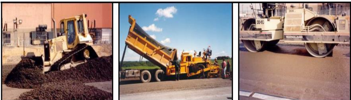
Figure 2-10: Equipement du compactage du BCR.
