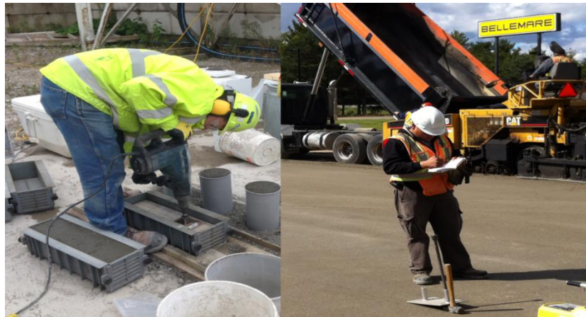
Figure 2-11: Contrôle du compactage
