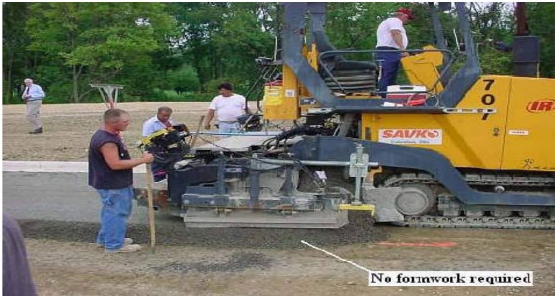
Figure 2-9: Mise en place du BCR
