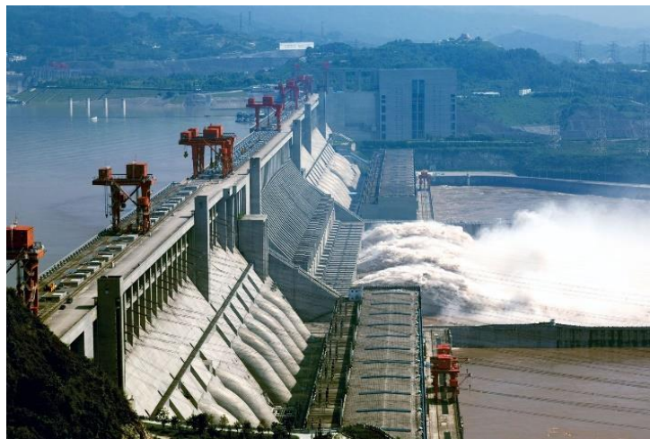
Figure 1-2 : Barrage des Trois Gorges, Chine
