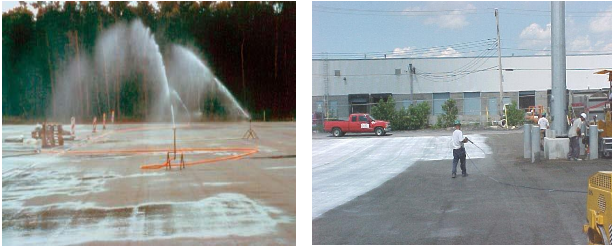
Figure 2-12 : Cure du béton
