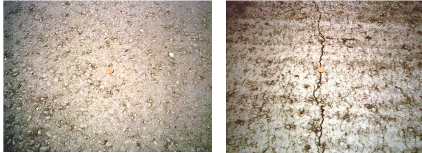
Figure 2-13: surface d'une chaussée en béton
