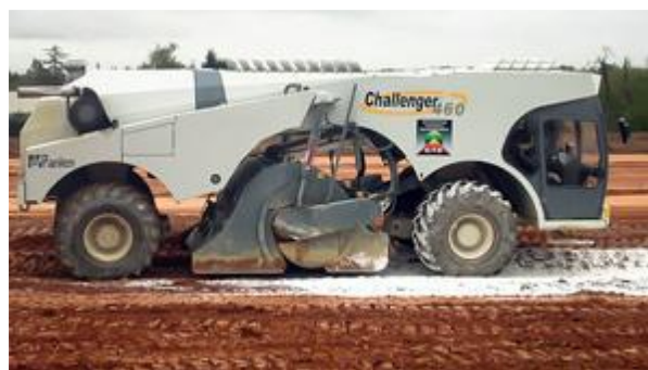
Figure 1.15: Chantier de traitement d'un sol à la chaux .
