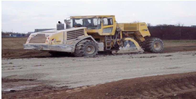
Figure 1.20: Chantier de traitement du sol au ciment.
