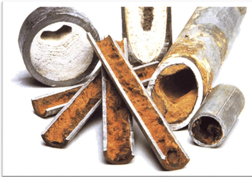
Figure I.6: Exemple de tartre dans des tuyaux
