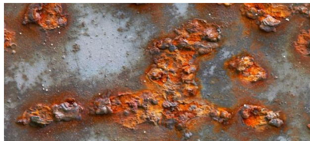
Figure I.5 : corrosion inter granulaire [10].
