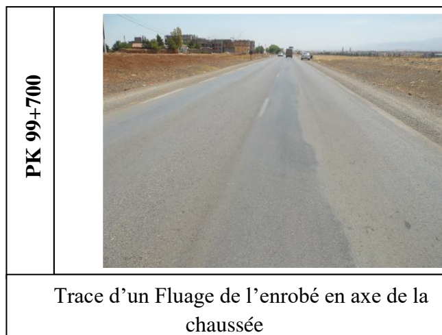
Dégradation apparus dans pk 97+000 et pk 99+000 [45]
