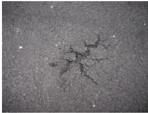
Figure II.15. Boursoufflure.
