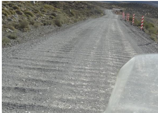
Figure II.22. La tôle ondulée [25].
