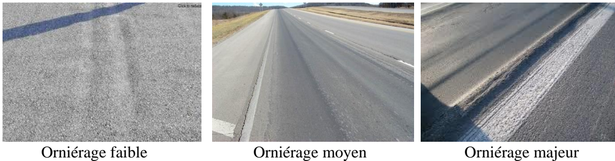
Figure II.1. Différents types d'orniérage en fonction de la taille.
