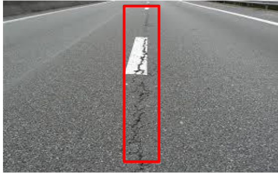
Figure II.6. Fissures longitudinales.
