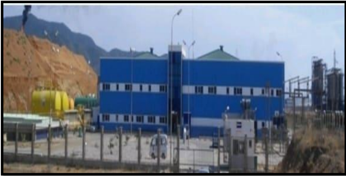
Figure II 1 : Présentation de la station de dessalement déssaladora _ Skikda
