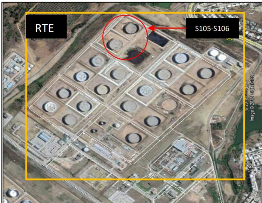
Figure I.4 : Vue aérienne du terminal RTE.
