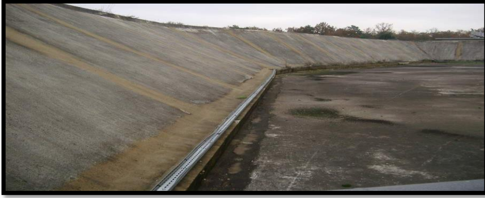
Figure III.2 : Cuvette de Rétention [14].
