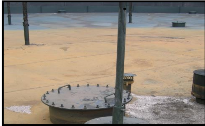
Figure III.8 : Exemple d'un Trou d'Homme sur le Toit [14].
