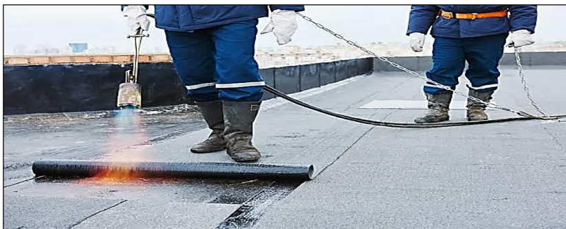
Figure II.5: Application des revêtements en bitume [42]
