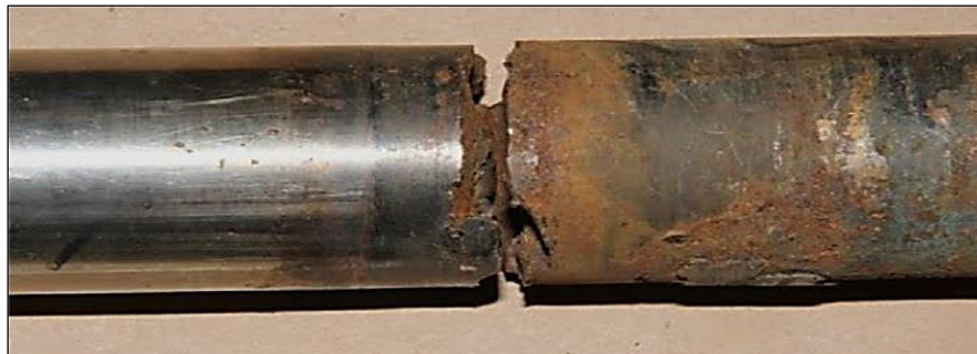
FigureI.14: Corrosion par fatigue [22]
