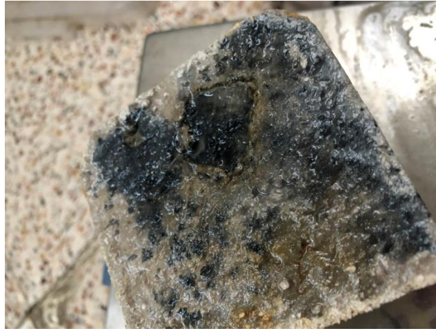
Figure V-16: Echantillon de béton après 120 jours de conservation dans 3.5% KOH.
